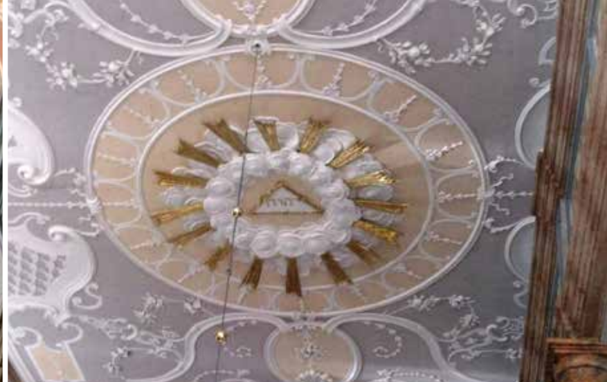
Mit 35.000 Stucknägeln wurden die Formen in der St. Ägidius-Kirche in Kulmbach-Melkendorf vorgestaltet, damit der Gips an der Decke festhielt.
